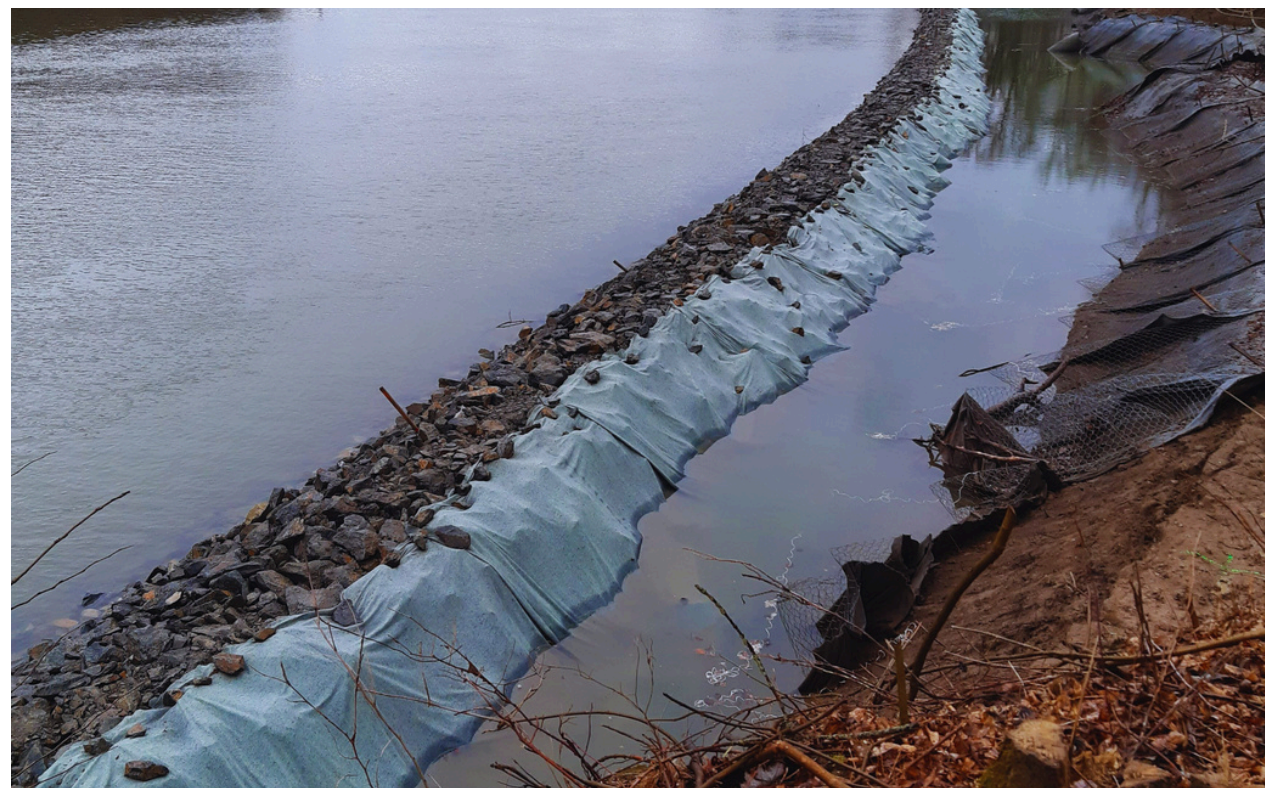
VEZETŐMŰ ÉPÍTÉS, TISZA
